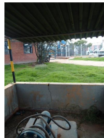
Foto 2. Caseta protectora pz 19 – 0021
