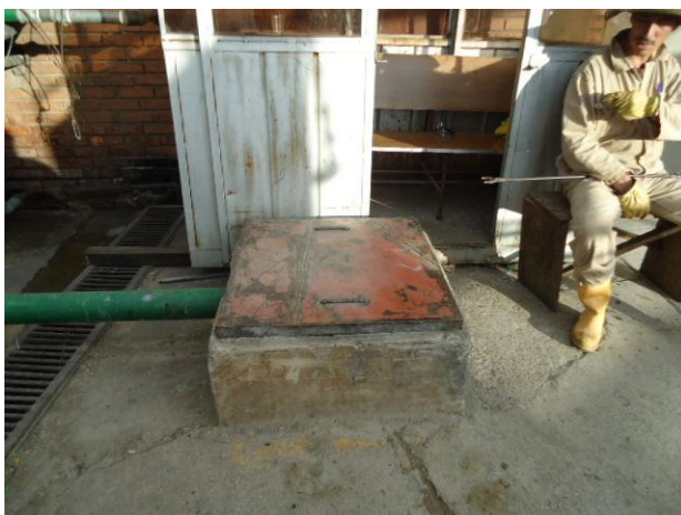
Foto 1. Protección pozo pz 19 – 0005
